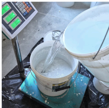
Vand tilsættes for at opnå den ønskede konsistens af blandingen som skal bruges til opgaven.
