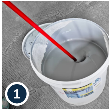
1 Part A omrøres til ensartet konsistens
