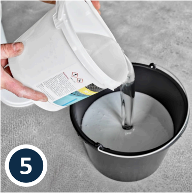
5 Blandingen omhældes til ren beholder for efterrøring.
