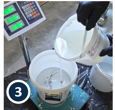
3 Part B tilsættes og afvejes til Part A
